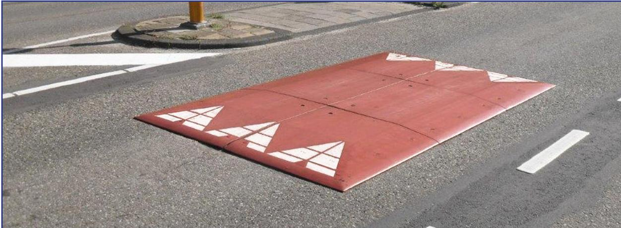
Zur Geschwindigkeitsdämpfung innerhalb von Tempo-10- und Tempo-30-Zonen. Sowohl für Knotenpunkte als auch auf Strecken (Straßenzüge) einsetzbar. Das Berliner Kissen verfügt über unterschiedlich steile Rampenneigungen. So ist (aus Fahrtrichtung gesehen) die seitliche Rampenneigung steiler als die der Front- und Abschlussanrampung.
