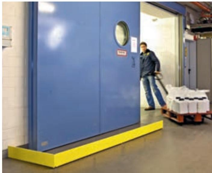
Häufig werden Lager-, Brandschutztüren und -tore beschädigt. Ursache: In der Sperrfläche im Rückfahrraum wurden Paletten/Gitterboxen abgestellt. Auch durch Staplerfahrer, die in diesen Bereich einfahren, während sich das Tor öffnet, können Schäden verursacht werden.
