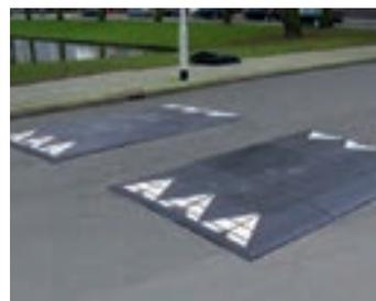
Kissens quer zur Fahrbahn erreicht. Hier sorgt die steilere Anrampung und der kurze Überfahrtsweg für eine deutlich unangenehmere, fahrdynamische Wirkung.
