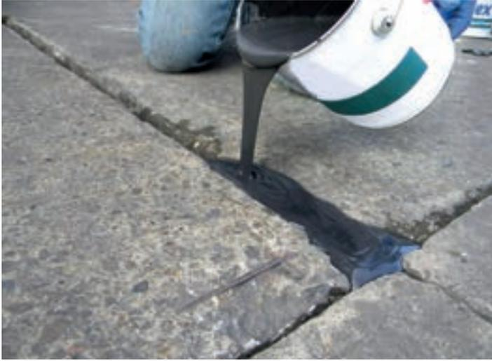
Extrem belastbares und beständiges Zweikomponenten-Gemisch mit schnellreaktivem Bindemittel für kurze Aushärtezeiten.
