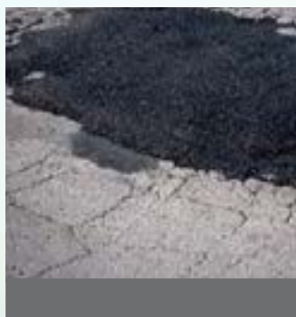
Dauerhafte Reparatur von Schlaglöchern
