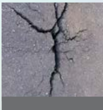
Verfüllung von Frostaufbrüchen und breiten Rissen
