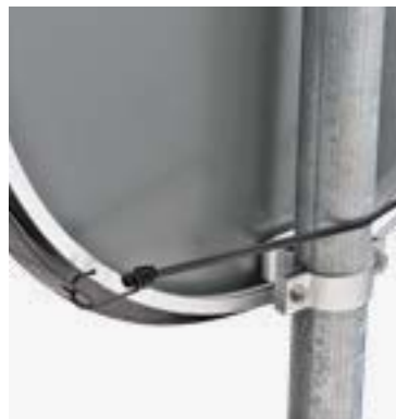
Detail: Spannband und Haken
